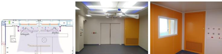
Nos recycleurs muraux ou plafonniers aspirent l'air et le recyclent directement dans le plafond soufflant. Cette technique garantie une hygiène supérieure. Le système permet toutes les implantations et configurations possibles sans modification de votre CTA. Il est en particulier facile d'utiliser le recyclage additionnel dans la salle pour améliorer le contrôle de la température, notamment en été.
